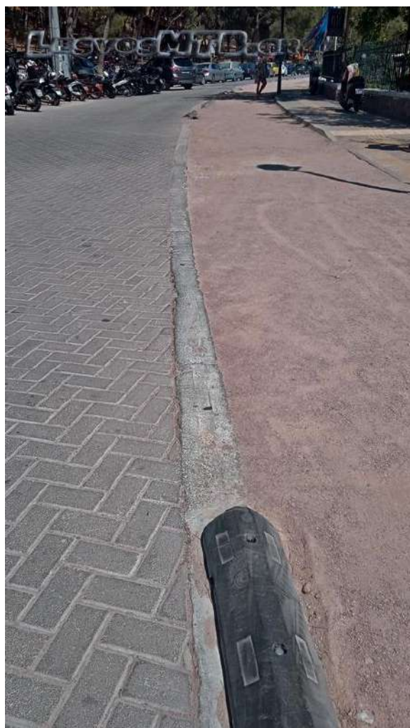
Καταστροφή του κρασπέδου και αποξήλωση των πλαστικών διαχωριστικών και μετακίνηση αυτών σε άλλες θέσεις
